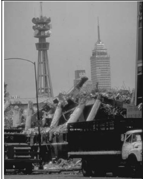
Figura 0 Estructuras de Televisa (Colapsada), Telmex (Antenas) y Torre Latinoamericana que sufrieron del mismo tipo de movimiento. Fuente: Karl V. Steinbrugge Collection, Earthquake Engineering Research Center; University of California at Berkeley.
